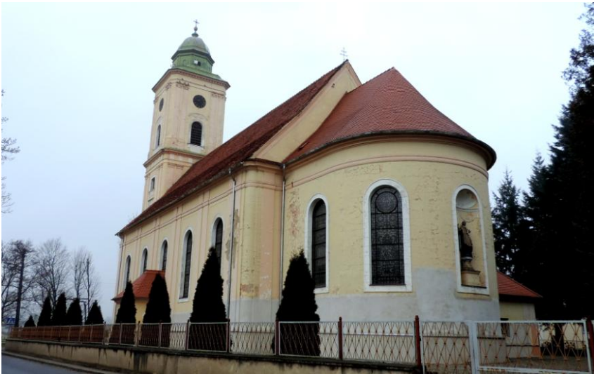
Zdjęcie nr 3. Kościół rzymsko - katolicki parafialny pw. Wniebowzięcia NMP, ul. Wrocławska 49, Bukowice
