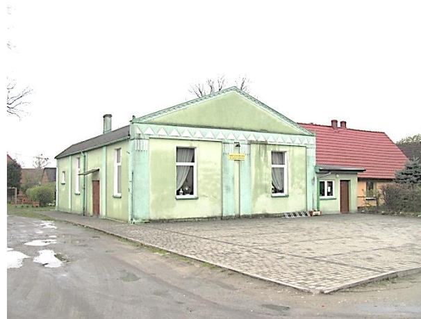
Fot. 95. Świetlica wiejska – obręb Łazy Wielkie
