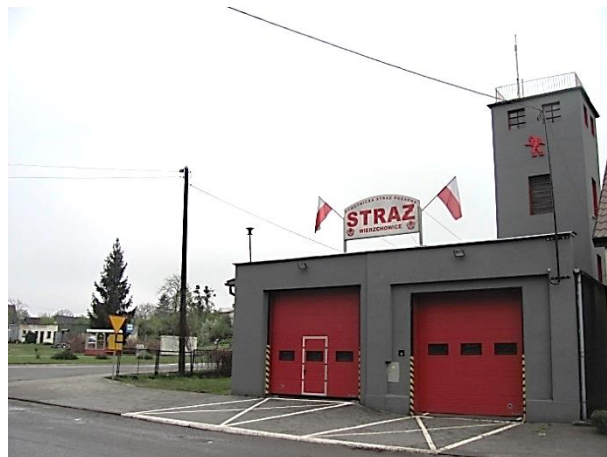
Fot. 48. Remiza strażacka OSP - obręb Wierzchowice
