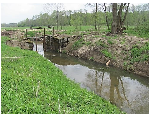
Fot. 73. Zastawka Prądnia II wymagająca poprawy stanu technicznego – obręb Brzostowo
