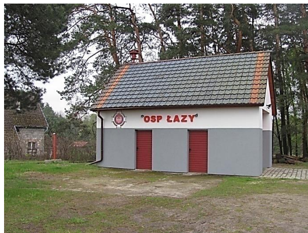
Fot. 56. Remiza strażacka OSP – obręb Łazy
