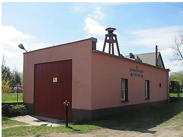
Fot. 55. Remiza strażacka OSP – obręb Bukowice
