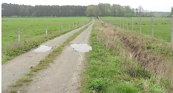
Fot. 82. Droga (dz.66/1) wskazana do przebudowy – obręb Dziewiętlin
