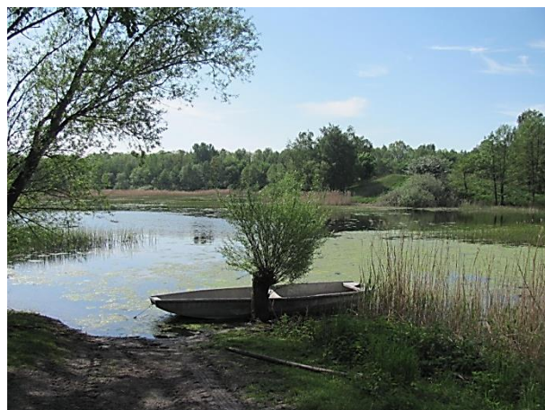
Fot. 109. Staw wymagający modernizacji infrastruktury – obręb Suliradzice
