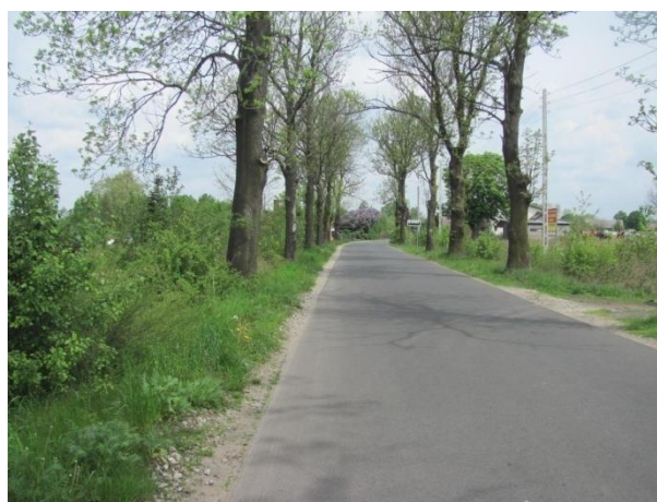
Fot. 40. Droga powiatowa przebudowana z dotacji UM - obręb Stara Huta
