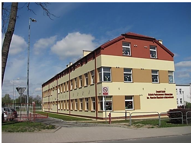
Fot. 47. Szkoła podstawowa i gimnazjum - obręb Bukowice
