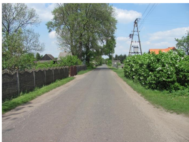
Fot. 39. Droga powiatowa w dobrym stanie technicznym - obręb Kotlarka
