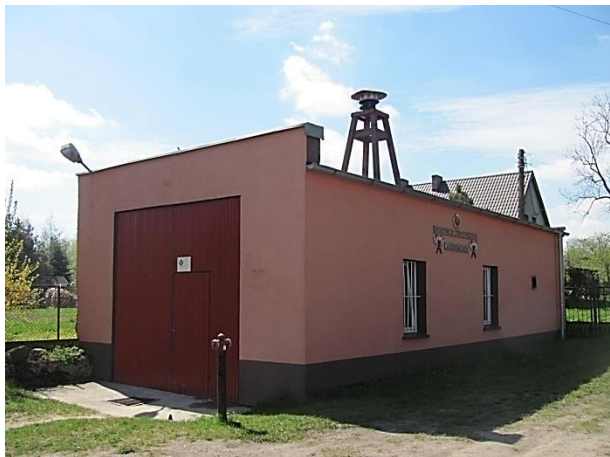
Fot. 55. Remiza strażacka OSP – obręb Bukowice
