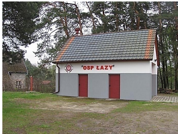
Fot. 56. Remiza strażacka OSP – obręb Łazy
