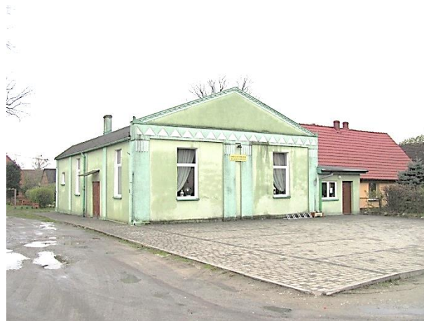
Fot. 95. Świetlica wiejska – obręb Łazy Wielkie
