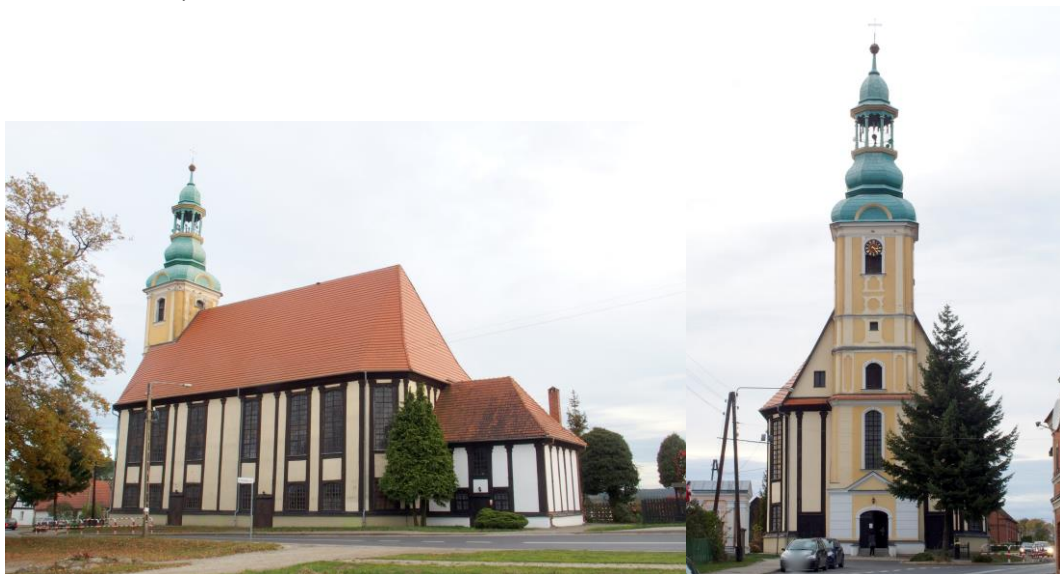
Zdjęcia nr 7, 8. Kościół parafialny pw. Narodzenia NMP, Wierzchowice, ul. Kościelna 19
